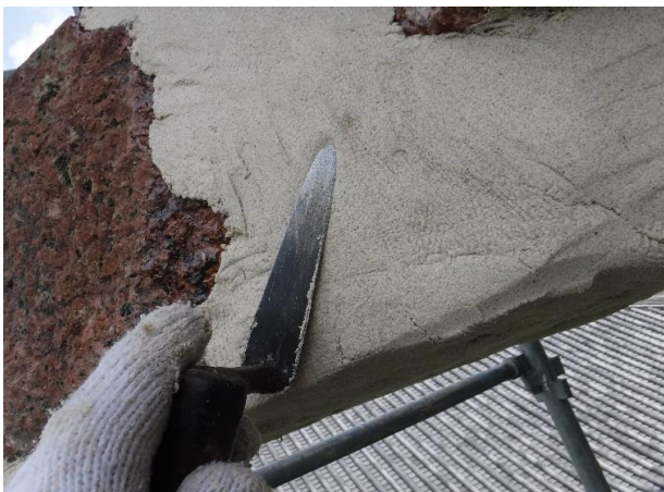
エポキシモルタルで石のデコボコを修整
