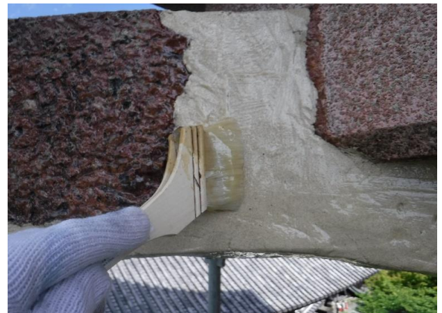
エポキシモルタルで石のデコボコを修整
