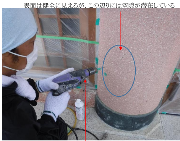
空隙の内部に向けて注入用の穴開け
