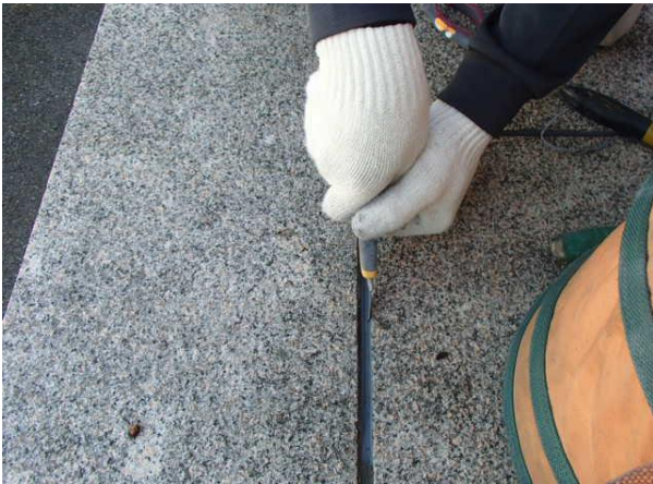
▲ 既存目地除去
