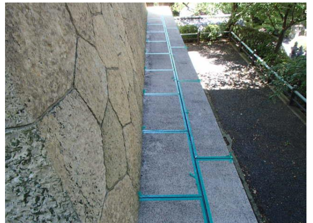
▲ 養生テープ貼り
