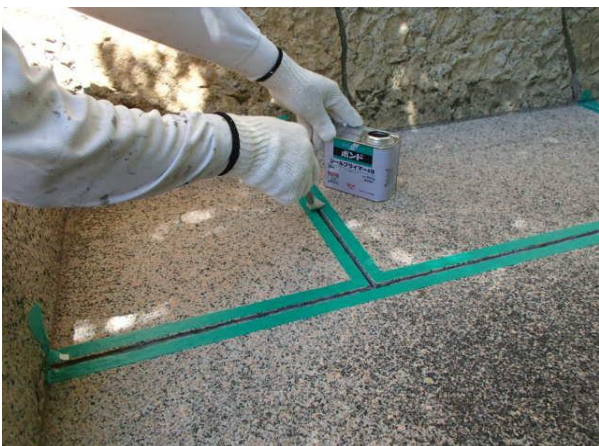
▲ プライマー塗り
